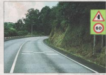
Las señales que se han colocado para reducir la velocidad en la AS-19.
